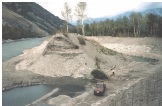
Wasserbauliche Neugestaltung: z.B. Umgestaltung des gesamten Gewässerabschnittes, Gerinneaufweitung und Vorlandabsenkung.
