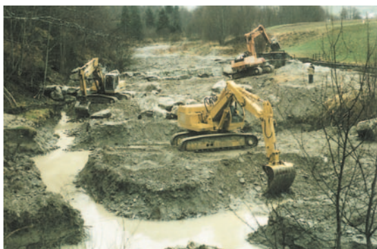
Wasserbauliche Neugestaltung: z.B. Umgestaltung des gesamten Gewässerabschnittes, Gerinneaufweitung und Vorlandabsenkung.
