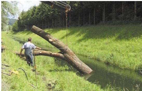
Instandhaltungsarbeiten: z.B. Einbringen von Totholz in kanalisierte Fließgewässer; Ufersicherung in Bereichen mit hohem Schadenspotential bei Hochwasser.
