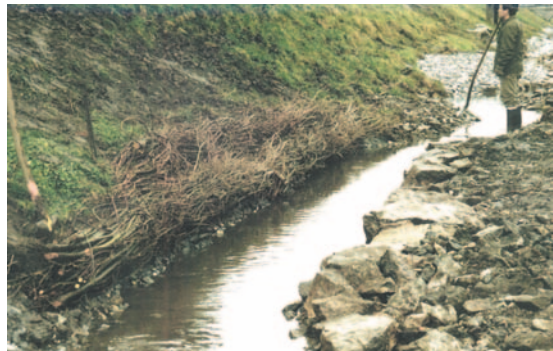
Instandhaltungsarbeiten: z.B. Einbringen von Totholz in kanalisierte Fließgewässer; Ufersicherung in Bereichen mit hohem Schadenspotential bei Hochwasser.
